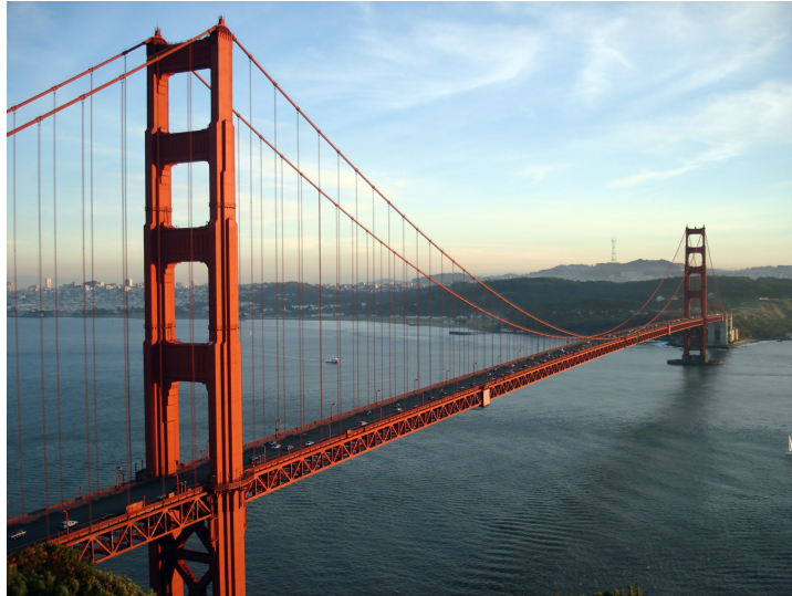
Figura 1: El puente "Golden Gate" de San Francisco, California.
